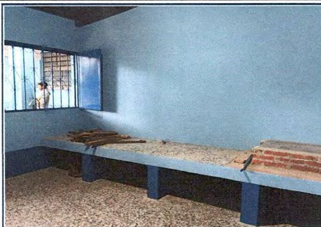
Foto 1: Cocina finalizada, la cual se mejoró con ventanas de metal, polletón y plancha de 3 ornillas.
