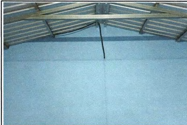
Foto 4: Se repelló en la parte superior del aula.
