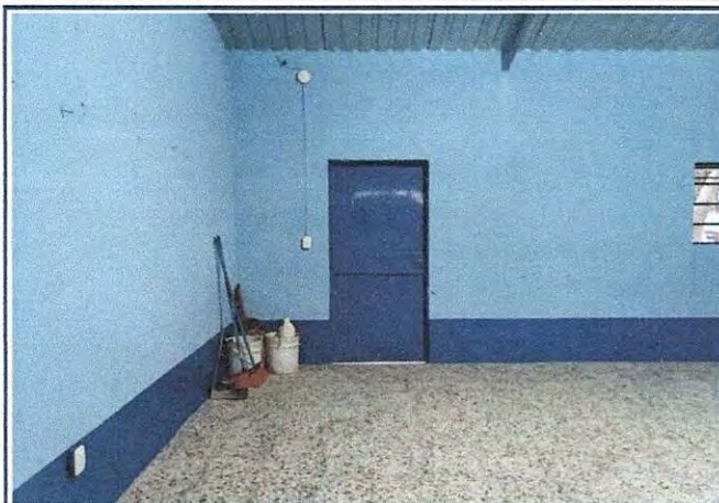
Foto1: Finalización de mejoramiento en aula y colocación de piso de granito.
